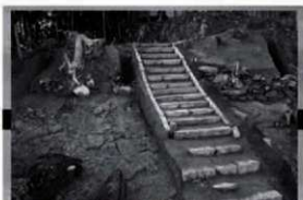
15 Ⅳ区1号平場1号石垣 岩盤の上に直接石を積んでいる。
