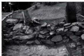
16 Ⅳ区1号平場1号石垣
