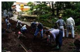
作業状況①
