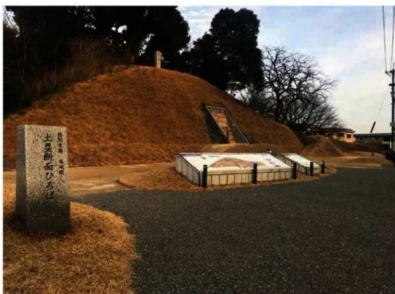
図5-75 土塁断面ひろばの竣工(大野城市側から)
