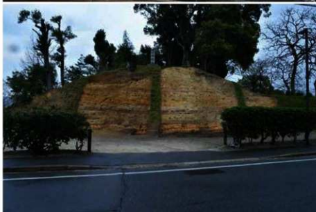
2 調査区近景 (西から)
