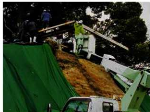
図 5-17 仮設公開施設設置工事の状況
