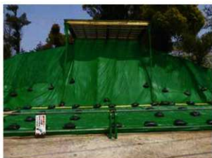
図 5-20 仮設公開施設設置完了 (正面から)
