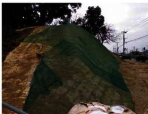
図 5-45 平成 26 年度工事の完了
