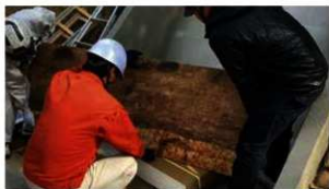
図 5-63 立体陶板の設置状況
