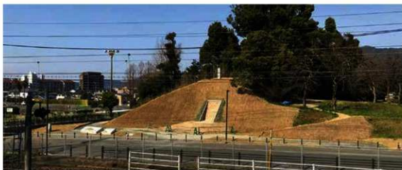
図 5-64 平成 28 年度工事の竣工
