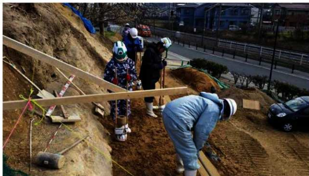
可能な限り往時の工法を踏襲した土塁の復元工事 (平成 26 年度)
