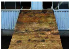
図資 3-14 弾性接着剤を下地に塗布し、陶板を固定
