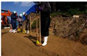
図 5-43 スロープの設置工事
