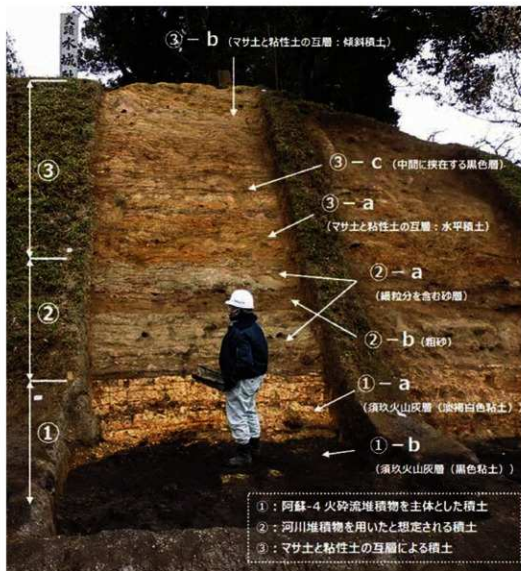
図5-36 土材に基づく積土区分と試料採取の位置
