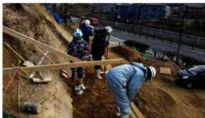
図 5-39 人力による土壘の一部復元状況
