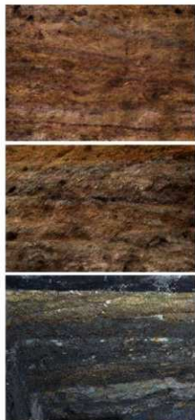
図4-11 水城跡各積土の状況 (上部・中部・下部)
