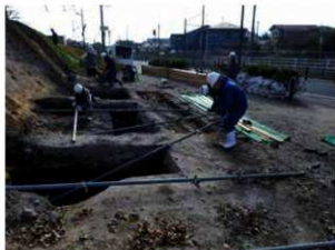
図 5-18 足場工事の状況
