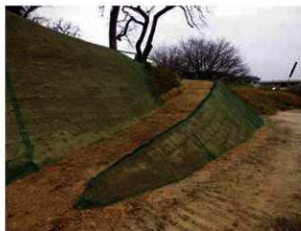
図 5-44 土壘上部への動線確保(スロープの設置)
