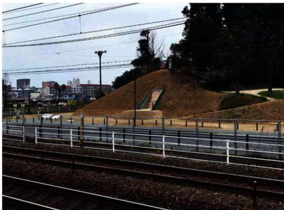
図5-74 土塁断面ひろばの竣工(線路側から)
