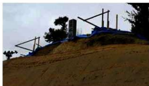
図 5-40 傾斜版築の再現
