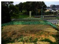
図 5-53 土塁天端の一部復元と石碑の据え直し
