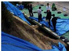
図資 3-1 土塁断面の確認
