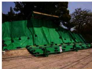
図 5-19 仮設公開施設設置完了 (大野城市側から)
