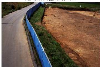
1区 SD03 完掘 (南東側から)
