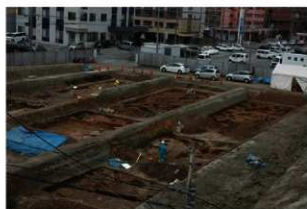
8) 調査区設定風景 (南東から)
