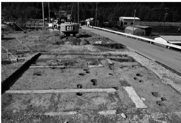
調査区（2区）全景（南東から）
