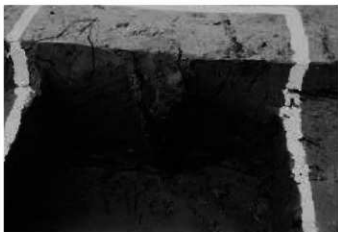
柱6 セクション (南から)
