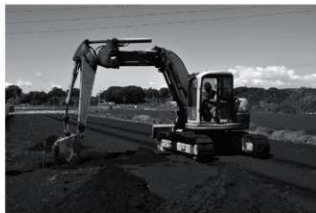
中東遺跡第 10 地点 表土剥ぎ
