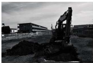
藤久保東遺跡第 28 地点 表土剥ぎ
