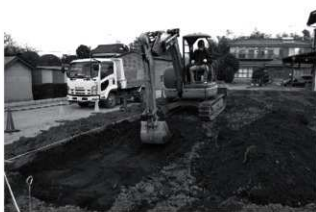
本村南遺跡第 13 地点 表土剥ぎ
