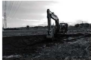
中東遺跡第 11 地点 埋め戻し
