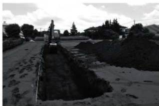
藤久保南遺跡第 2 地点 表土剥ぎ
