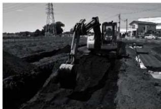
東永久保遺跡第 2 地点 (発掘) 表土剥ぎ
