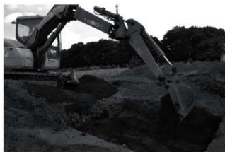
中東遺跡第 12 地点 埋め戻し
