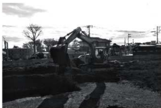
藤久保東遺跡第 28 地点 埋め戻し
