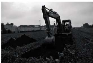
東永久保遺跡第 2 地点 表土剥ぎ
