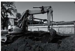
中東遺跡第 10 地点 埋め戻し
