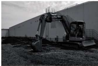
中東遺跡第 12 地点 表土剥ぎ
