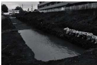
藤久保東遺跡第 28 地点 台風による水没状況
