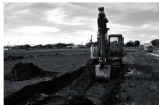
中東遺跡第 11 地点 表土剥ぎ
