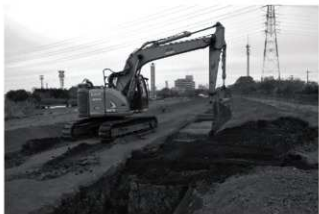
東永久保南遺跡第 1 地点 埋め戻し
