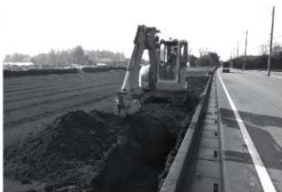
東永久保南遺跡（近接地） 埋め戻し
