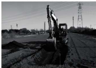
東永久保南遺跡第 1 地点 表土剥ぎ
