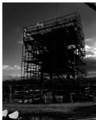
【修理中の復元楼閣】
