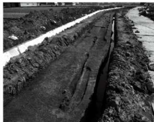
写真19-2 第2トレンチ完掘全景（北から）
