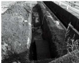
写真34-1 第2トレンチ完掘全景 (西から)
