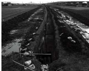
写真19-1 第1トレンチ完掘全景（北から）
