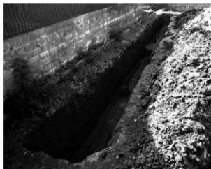
写真 11-2 南北方向完掘全景 (南東から)
