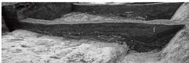
第1号溝跡・第1号性格不明遺構 断面（北から）
