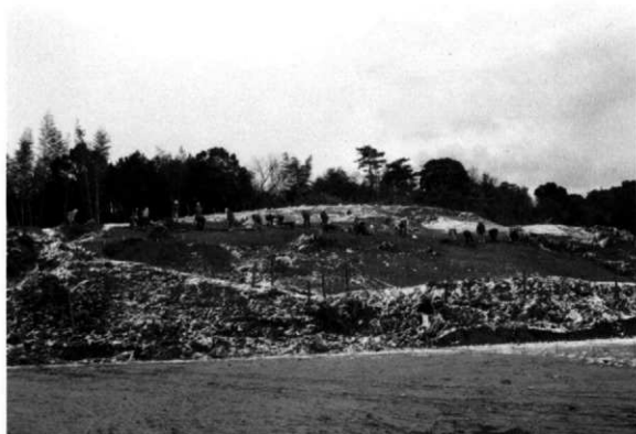
2. トヲノ尾遺跡南斜面作業風景（南から）
