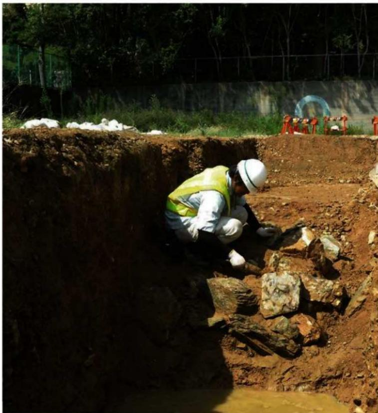
石垣と堀を確認（表面①の位置） 本丸東側に構築された石垣と堀を確認しました。石垣はチャートの自然石を用いて造られています。垣の幅は約10mあり、深さは2m以上あります。
