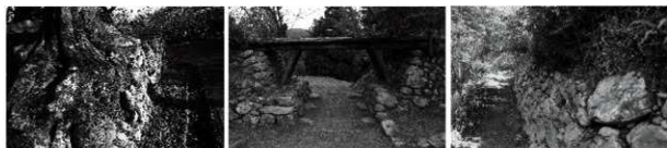
大手門石垣付近の樹木 (①)
