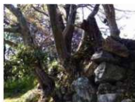
石垣の保存に影響を与え、 安全性が懸念される樹木 (⑦)
