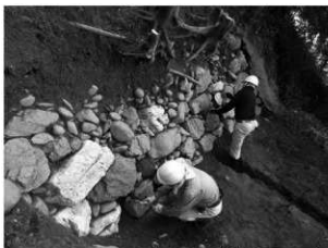
Fig.43 西の丸I石垣検出状況
