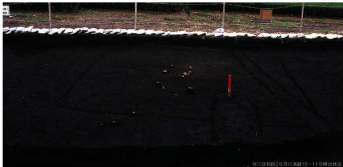
髹髹建建物物22号号及及CC溝溝路路10、11号号樓樓出出状状况况
