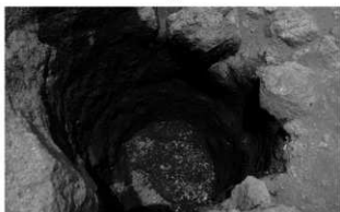
P1 壁面状況
