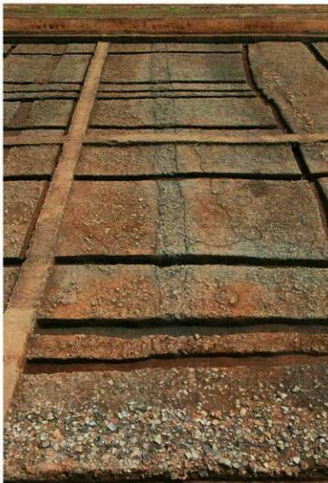
写真④ 南北暗渠
