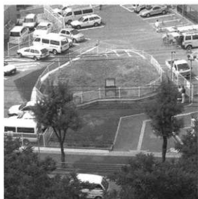
写真7 工事後の全景(平成16年6月撮影,南から)
