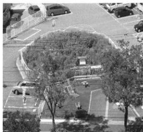
写真6 工事前の全景(平成15年8月撮影,南から)
