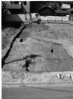
写真3 南門・回廊検出状況(南から)
