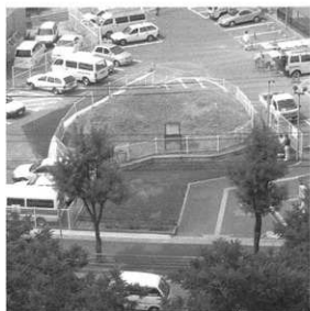
写真7 工事後の全景(平成16年6月撮影,南から)
