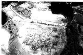
C1, 2区 空中写真(南から)
