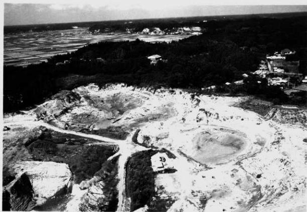
C4・5・6区 空中写真(南から)
