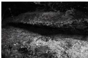
トレンチB20たち割り状況(北より)
