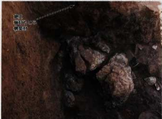
8-II号窯 燃焼部 仮設天井崩落土検出アップ (右)
