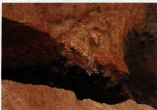
1-A号窯 焼成部口上位の修復痕跡
