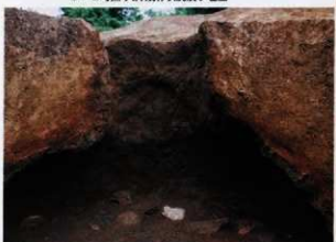
8-II号窯 煙道
