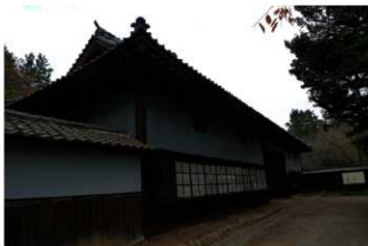
修理工事完了後の長屋門
