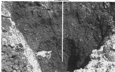
(3) トレンチ掘削状況
