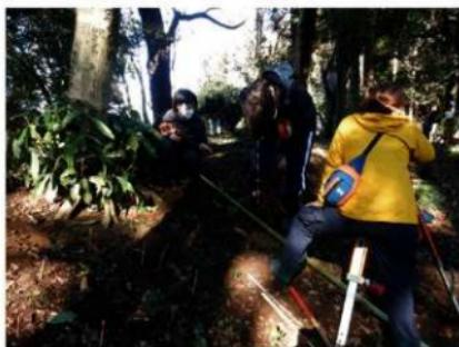
写真1 トータルステーションによる測距作業
