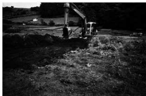
4. 03 船津7古墳群7地区 掘削状況
