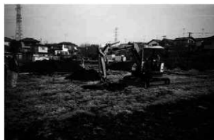
3. 16 舟久保遺跡 45 地区 掘削状況
