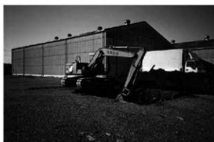
5. 13 沖田遺跡 122 次 掘削状況
