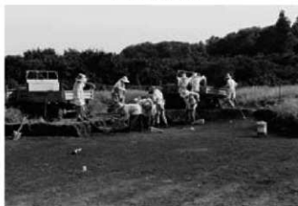
3 表土剥ぎ作業状況
