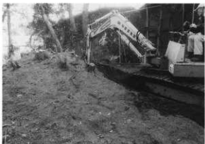
(7) 2号塚重機による掘削
