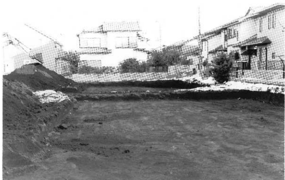
— 1 高津新田野馬堀遺跡調査区近景
