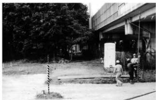
(1) 調査前状況 (西から)
