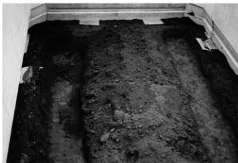
(2) 沼上遺跡トレンチ完掘状況
