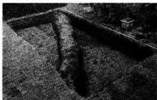
3. T2トレンチ掘削状況
