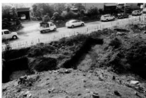
(6) トレンチ完掘状況-2-
