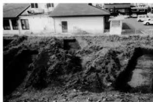
(5) トレンチ完掘状況-1-
