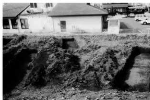
(5) トレンチ完掘状況-1-
