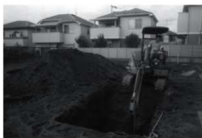
川崎山遺跡 v 地点 トレンチ掘削状況
