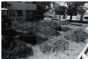
川崎山遺跡 u 地点 トレンチ状況
