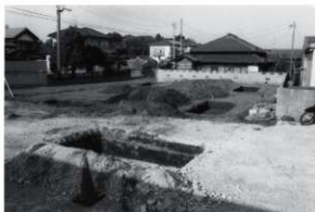
保品南遺跡 c 地点 トレンチ状況
