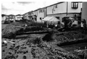
1. トレンチ掘削状況
