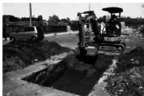
2. トレンチ掘削作業
