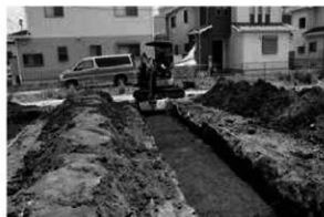
2. トレンチ掘削作業
