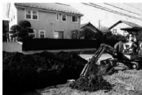
2. トレンチ掘削作業
