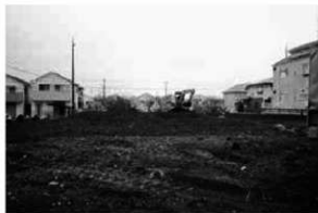
8. 埋め戻し作業
