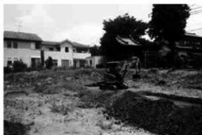
2. 表土掘削作業
