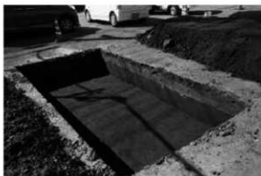
5. 6 トレンチ確認面検出状況
