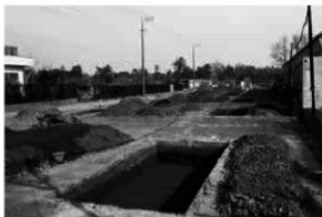
7. トレンチ掘削状況
