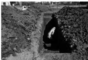
3. トレンチ清掃作業
