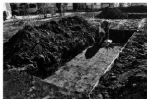
2. トレンチ清掃作業
