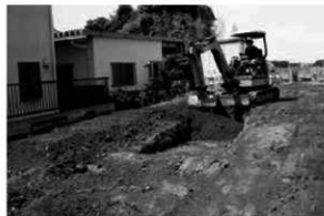
6. 埋め戻し作業
