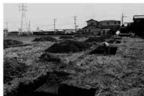
2. トレンチ掘削状況
