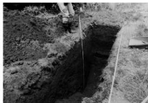
4. 2トレンチ掘削状況
