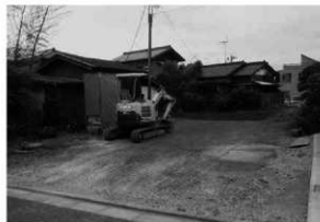
6. 埋め戻し完了状況
