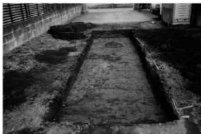
5. トレンチ内落ち込み検出状況
