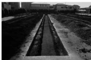
4. 4トレンチ確認面検出状況
