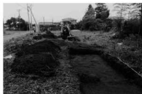
2. トレンチ掘削状況
