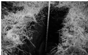
3. トレンチ掘削状況
