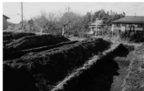
2. トレンチ掘削状況
