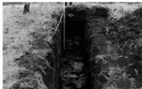
4. トレンチ掘削状況
