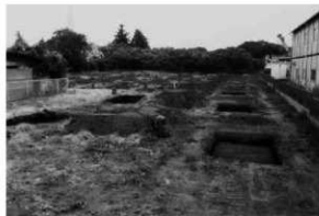
4. トレンチ掘削状況
