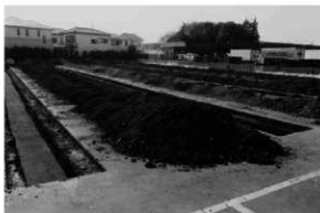
7. トレンチ完掘状況
