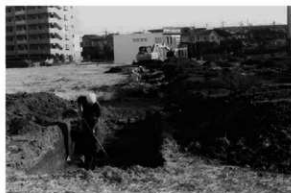
2. トレンチ掘削状況
