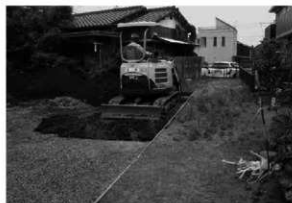
2. トレンチ掘削状況
