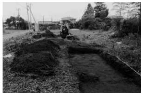
2. トレンチ掘削状況
