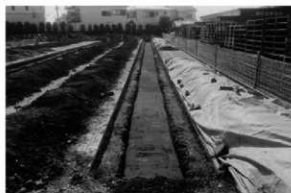
2. 1トレンチ遺構確認面検出状況
