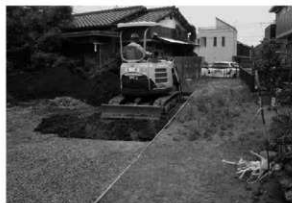
2. トレンチ掘削状況
