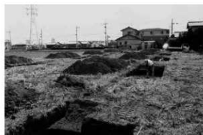
2. トレンチ掘削状況
