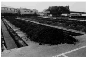
7. トレンチ完掘状況
