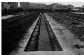
4. 4トレンチ確認面検出状況
