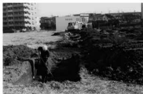
2. トレンチ掘削状況
