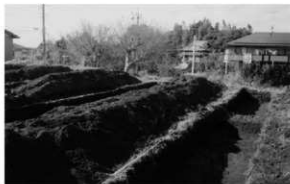
2. トレンチ掘削状況
