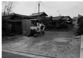
6. 埋め戻し完了状況
