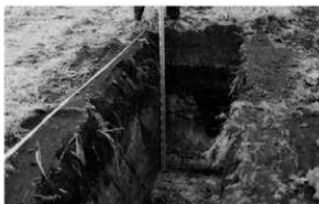
3. トレンチ掘削状況
