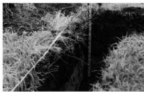
4. トレンチ掘削状況
