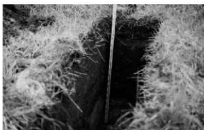
3. トレンチ掘削状況
