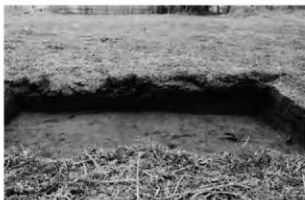
3. F10-1トレンチ掘削状況
