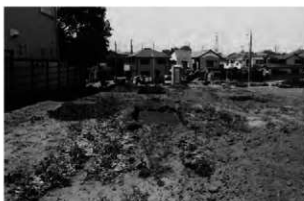
3. トレンチ掘削状況
