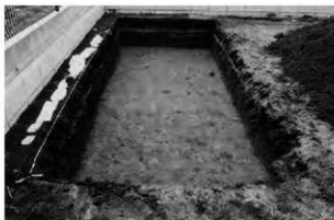
4. Aトレンチ掘削状況
