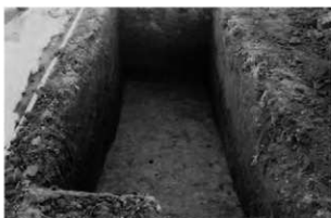
3. Bトレンチ検出状況
