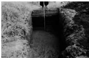
4. B2-4トレンチ掘削状況
