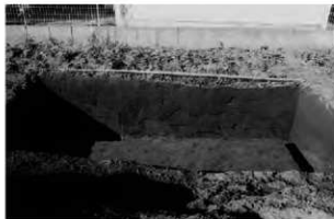
3. B2-1トレンチ土層断面
