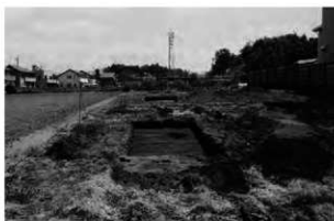
2. トレンチ掘削状況
