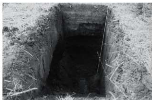
(4) A-10G掘削状況
