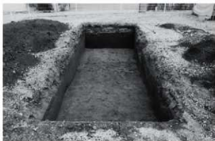
(2) AT掘削状況
