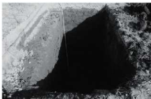
(3) A-2G掘削状況
