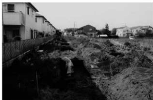
(1) 西側地点調査状況
