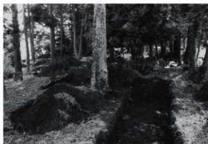
(6) トレンチ掘削状況
