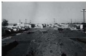
(5) トレンチ掘削状況
