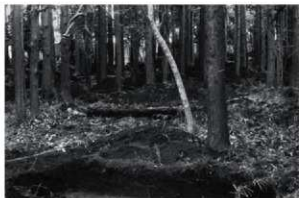
(6) トレンチ掘削状況
