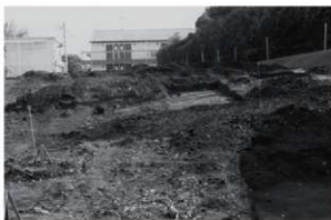
(6) トレンチ掘削状況
