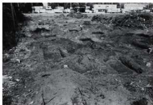
(6) トレンチ掘削状況
