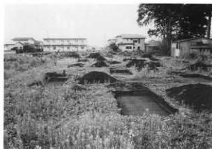
(2) トレンチ掘り下げ状況
