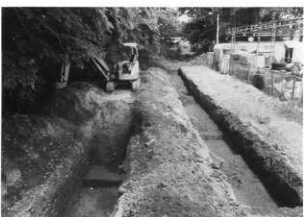
(7) トレンチ掘り下げ状況
