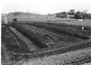
(3) トレンチ掘り下げ状況
