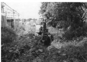
(6) トレンチ掘り下げ状況
