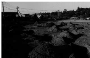
(2) トレンチ掘削状況
