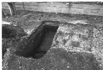
(3) 南台遺跡b地点 トレンチ掘削状況
