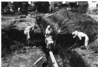
(7) 持田遺跡C地点・正覚院館跡d地点 工事中の調査状況
