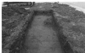
(1) トレンチ掘削状況
