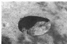
ビット完掘状況
