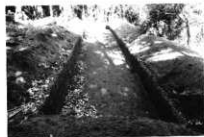
第4トレンチ完掘状況
