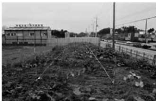
2. トレンチ設定状況
