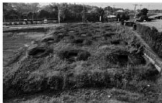
3. トレンチ掘削状況
